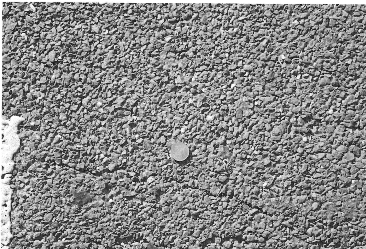
Obr. 1: Povrch Viaphone na ulici V Holešovičkách, v Praze, u zastávky Vychovatelna (úsek 2), před čištěním. (Viditelné znečištění, trhliny.)
