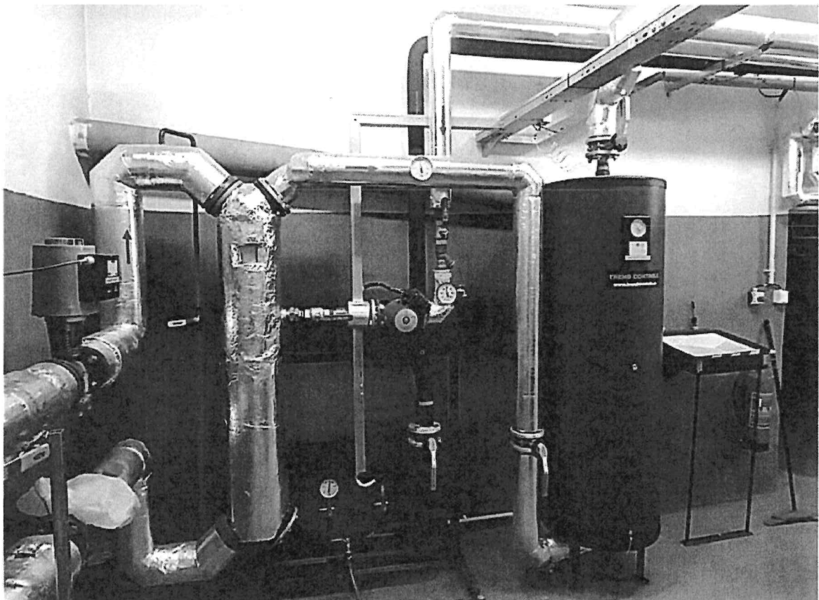
Pohled na zdroj hluku - cirkulační čerpadlo teplé vody zn. Grundfos, typ: UPS 32-120F B náležející k okruhu pro rozvod teplé vody do bytového domu instalované v prostoru výměňkové stanice umístěné v 1.PP bytového domu č.p.21/144 v ul. Ruská, Praha 10 – Vršovice
