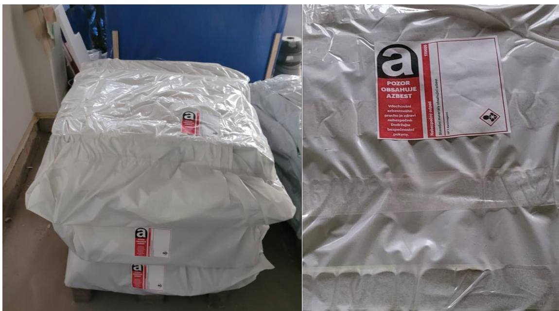
Fotografie č. 15, 16: zabalený a označený odpad s materiálem obsahujícím azbest před materiálovou propustí a detail označení
