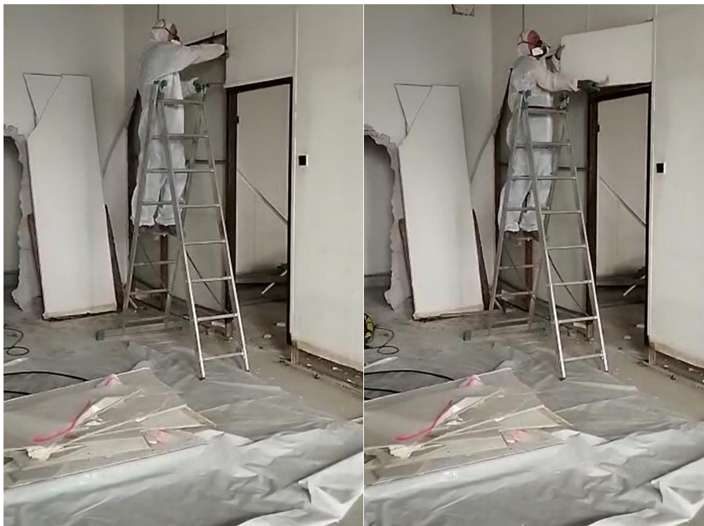
Fotografie č. 11, 12: enkapsulace (stříkacím zařízením) azbestocementových příček certifikovaným fixačním prostředkem před demontáží
