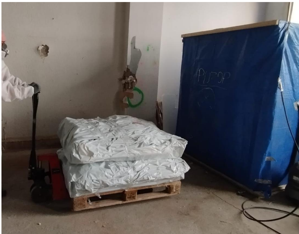
Fotografie č. 19, 20: dekontaminace zabaleného NO – osátí vysavačem s hepafiltrem a otření vlhkým hadrem/tkaninou
