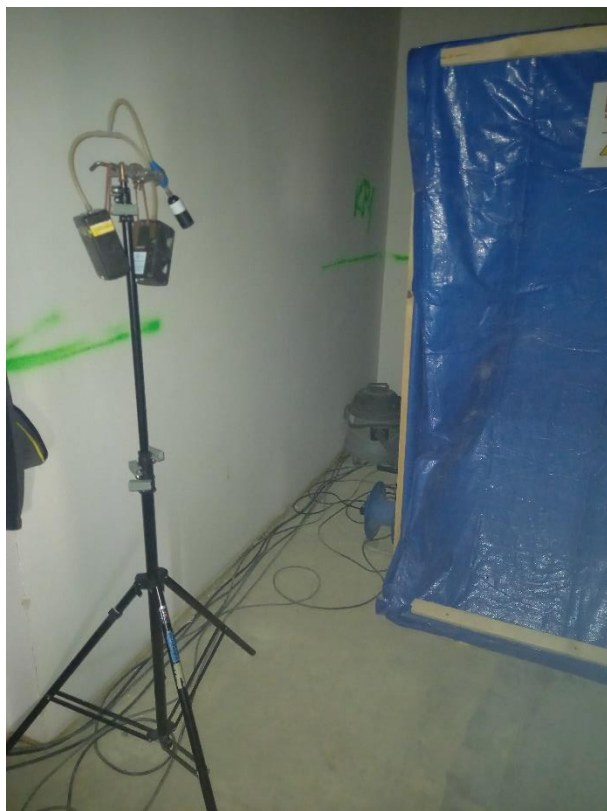
Fotografie č. 10: odstraňování materiálu s obsahem azbestu (v rámci KP1A – budova B, 6.NP)
