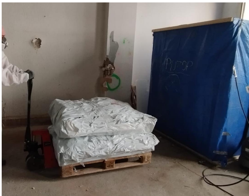
Fotografie č. 19, 20: dekontaminace zabaleného NO – osátí vysavačem s hepafiltrem a oření vlhkým hadrem/tkaninou
