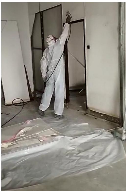
Fotografie č. 11, 12: enkapsulace (stříkacím zařízením) azbestocementových příček certifikovaným fixačním prostředkem před demontáží
