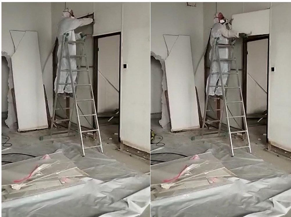
Fotografie č. 13, 14: demontáž azbestocementových desek (příčky) ručním náradím a balení demontovaných obkladových desek Pyral do PE pytlů.
